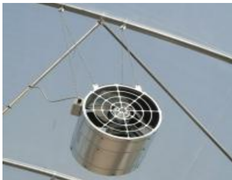
Рис. 20. Система рециркуляции воздуха в теплице
