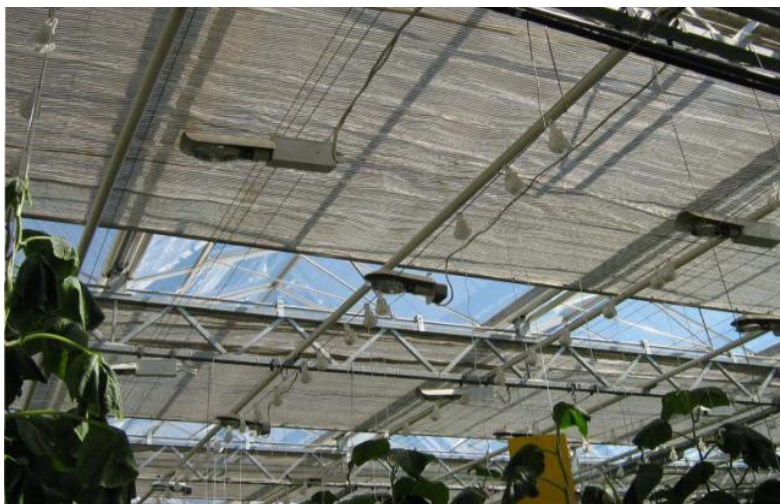
Рис. 15. Система горизонтального зашторивания
