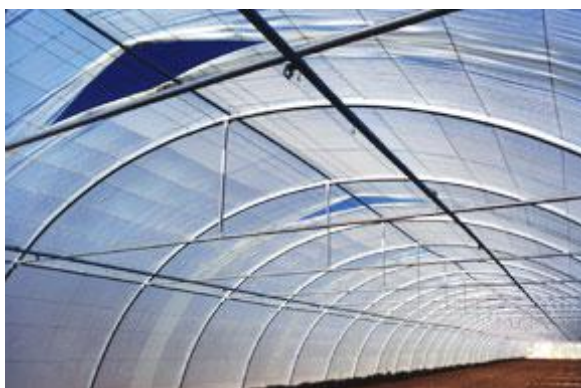
Рис. 27. Раздвижное покрытие в коньке теплицы
