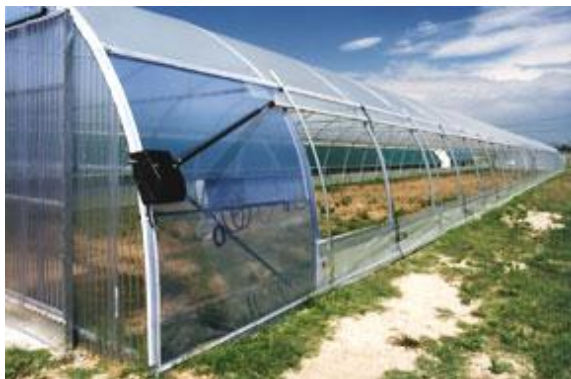
Рис. 26. Боковая вентиляция теплицы с противовеетровой сеткой
