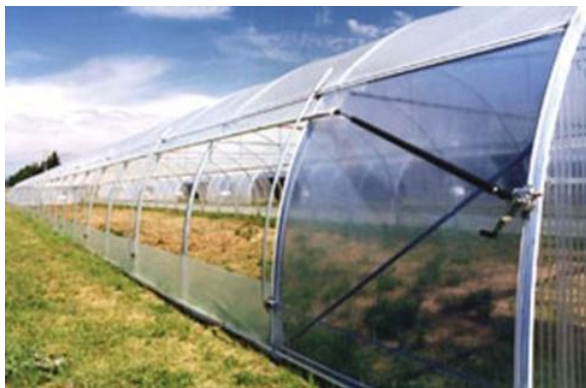
Рис. 25. Боковая вентиляция теплицы с автоматическим приводом
